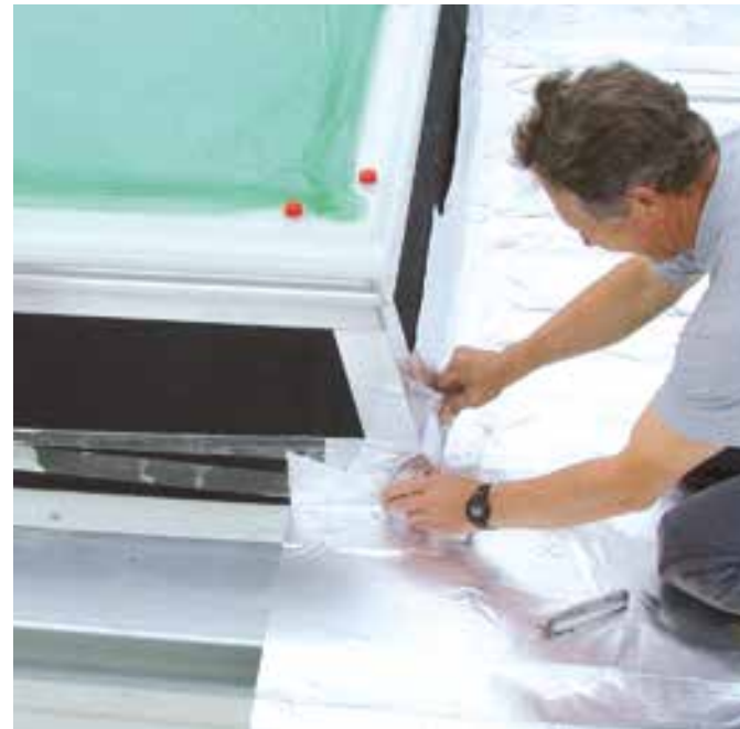
Detailausführung Lichtkuppelanschluss
