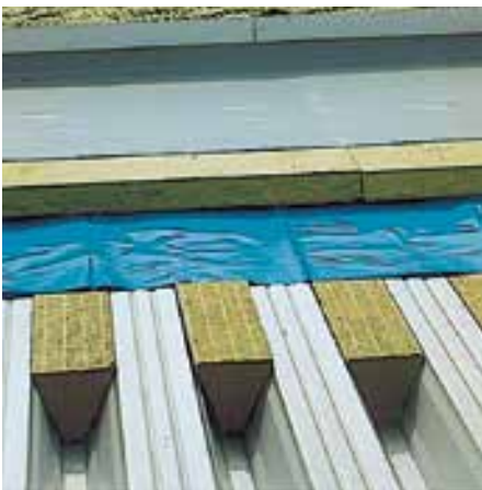
Brandschutz-Profilfüller zum Lastabtrag
