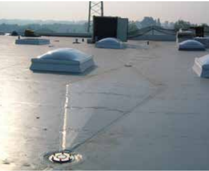
Punktentwässerung entlang der Kehllinien
