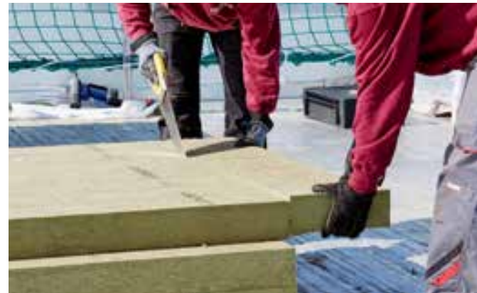
Die Dämmplatten lassen sich leicht zuschneiden.
