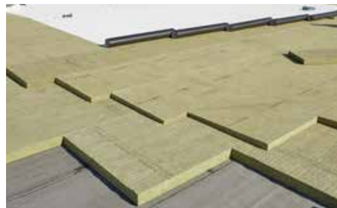
Die Verlegung der Dämmplatten erfolgt im Verband.
