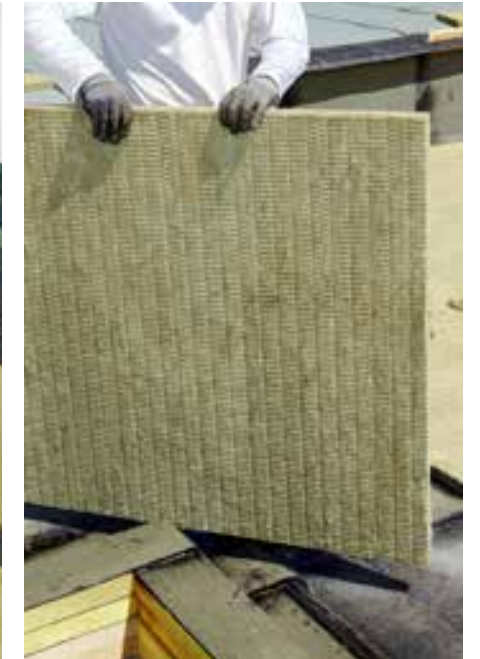
Verlegung der RP-TF auf ausgebessertem altem Dachaufbau
