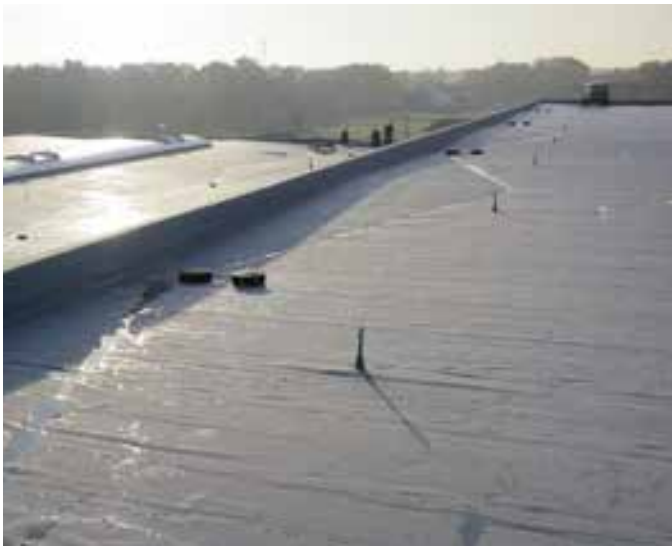
Punktentwässerung entlang der Attika
