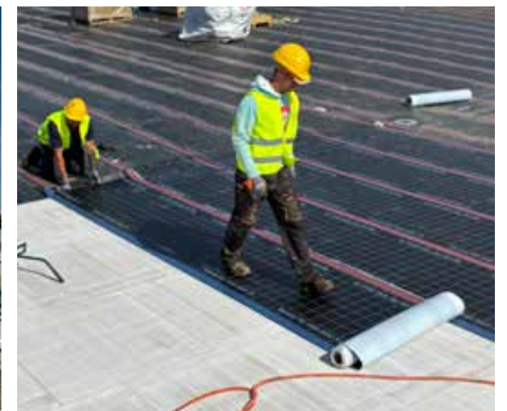
Dachaufbau verklebt
