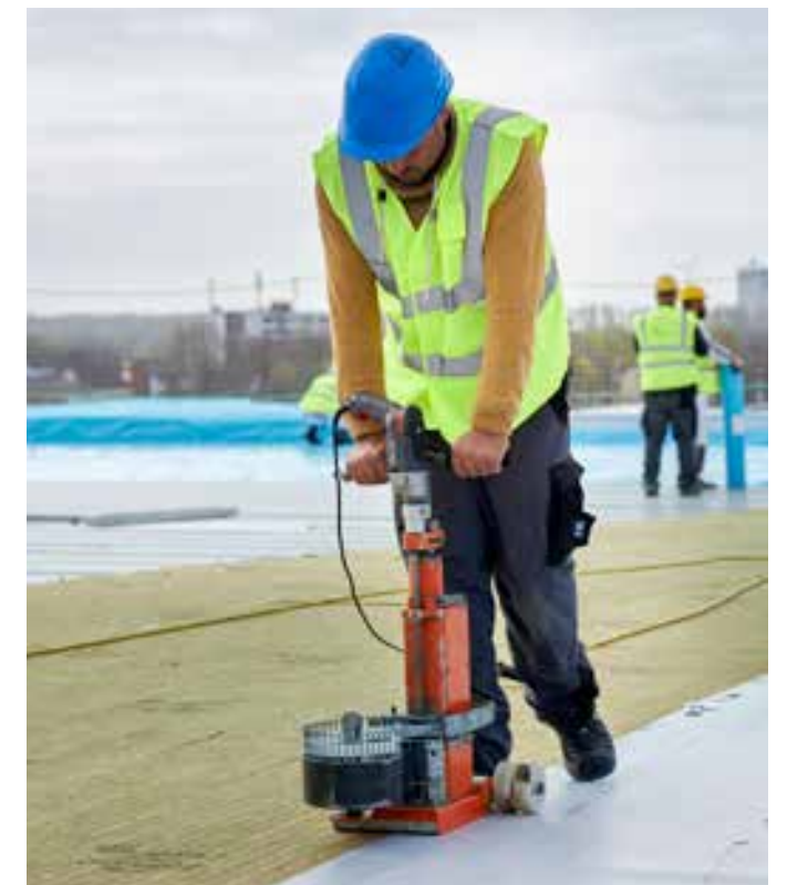
Dachaufbau mechanisch befestigt
