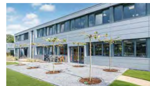
Coesfeld , 2-geschossiges Bürogebäude, BGF 1.021 m 2
