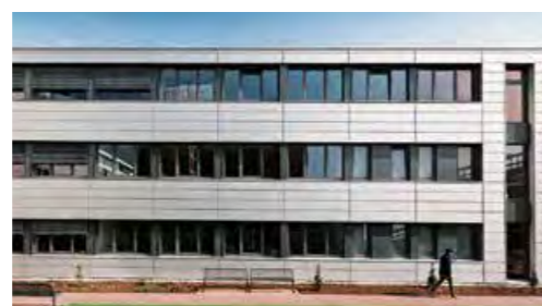
Mannheim , zwei 3-geschossige Bürogebäude, BGF 5.265 m 2
