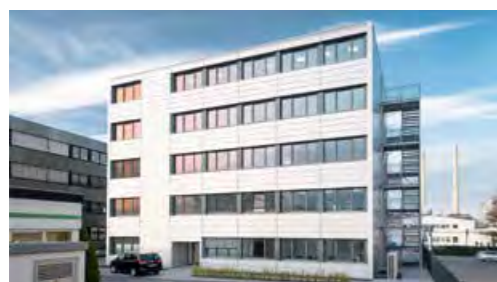
Neckarsulm , 5-geschossiges Bürogebäude, BGF 1.385 m 2
