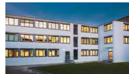
Stuttgart , 3-geschossiges Bürogebäude, BGF 4.910 m 2
