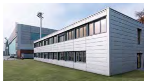
Wunstorf , 2-geschossiges Bürogebäude, BGF 870 m 2
