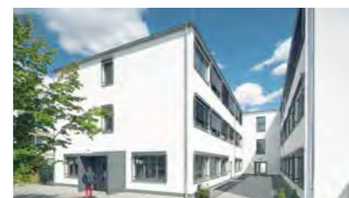
Offenbach , 3-geschossiges Bürogebäude, BGF 2.709 m 2
