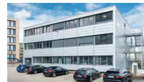
Kornwestheim , 3-geschossiges Bürogebäude, BGF 830 m 2
