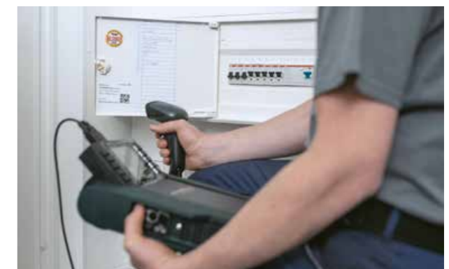
Die dokumentensichere Elektro-Prüfung gemäß VDE gewährleistet die Sicherheit der Anlagen.
