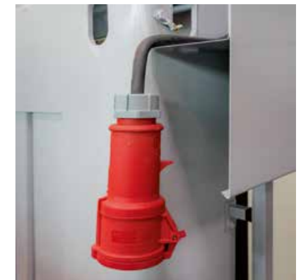
Elektro-Verbindung hinter der Attikablende
