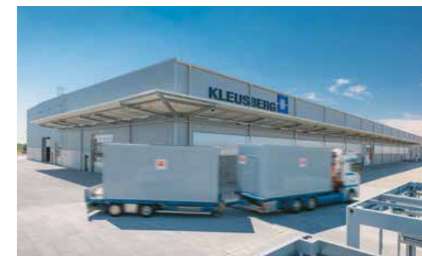
Termingerechte Auslieferung der Mieteinheiten
