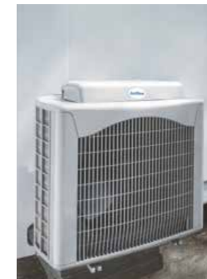
Fest angebrachtes Außengerät
