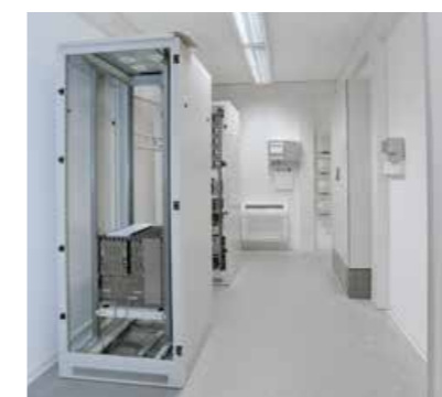
Technikraum und Servertechnik
