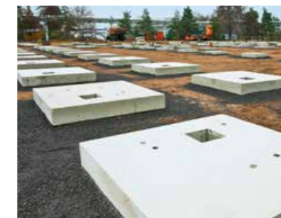
Fundamentierung mit Beton-Fertigteileplatten
