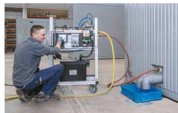
Sanitäreinheiten durchlaufen eine Desinfektion der Frischwasserleitungen gemäß Trinkwasserverordnung.
