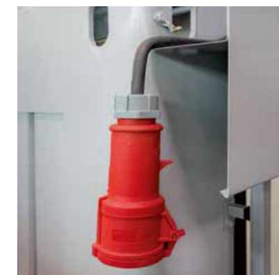
Elektro-Verbindung hinter der Attikablende
