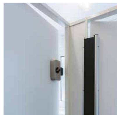
Fingerklemmschutz an Sanitärtür
