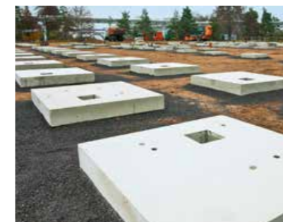
Fundamentierung mit Beton-Fertigteileplatten
