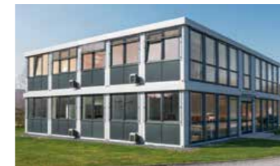
Fassade mit anthrazit lackierten Kassetten unterhalb der Fenster
