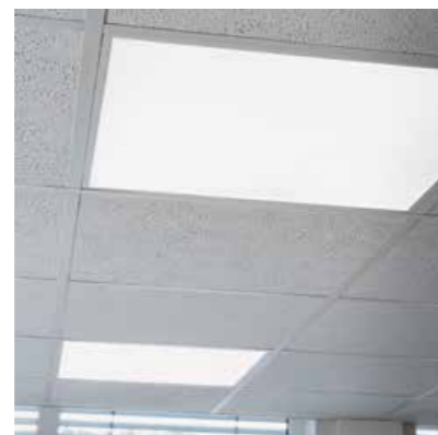
Akustikdecke mit LED-Beleuchtung
