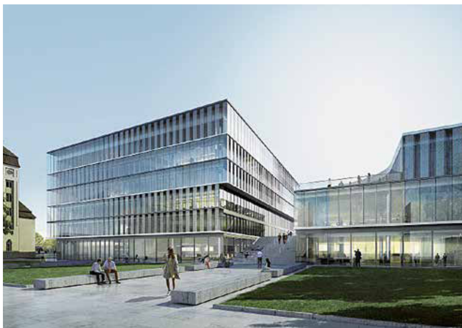
Durch seine großflächige Glasfassade vermittelt der Neubau Offenheit und Transparenz auch nach außen.
