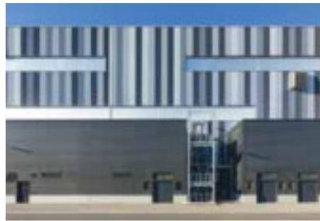
Die gedämmte Trapezblechfassade sorgt mit Profiltafeln in unterschiedlichen Grautönen für ein lebendiges Erscheinungsbild.
