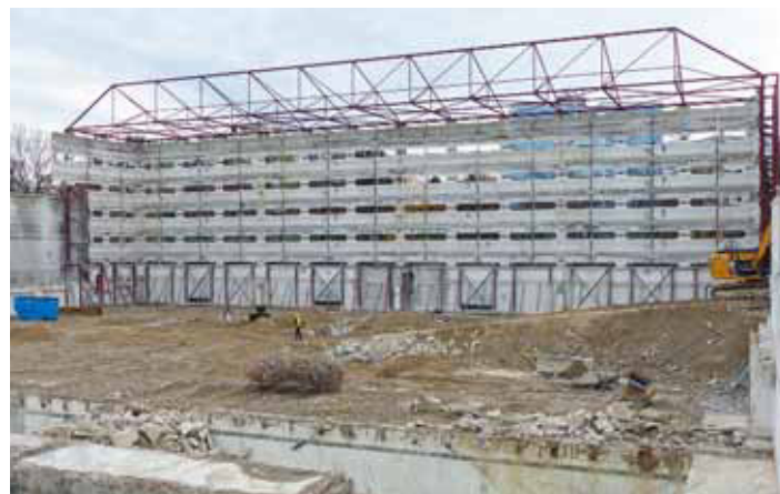
32 Sanierung historisches Parkhaus BMW Group, München
