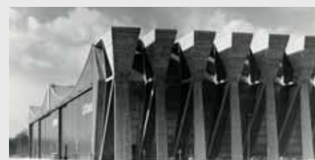
ABB, Lufthansa-Wartungshalle V, Frankfurt am Main, 1972.
