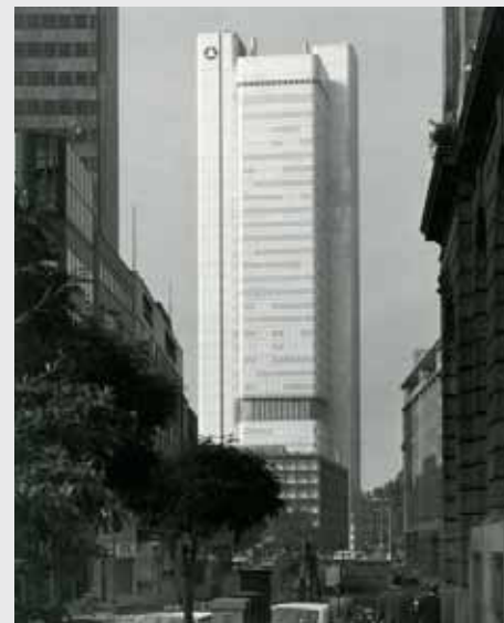
ABB, Dresdner-Bank-Hochhaus, Frankfurt am Main, 1980.
