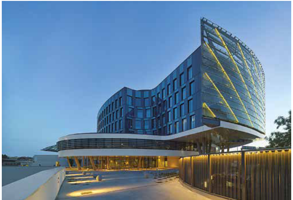
Im oberen Bereich gelangt man über die U-Bahn-Station Erdberg direkt zum Haupteingang mit der Lobby.
