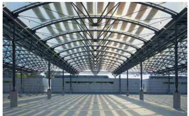
32 Foliendach mit Photovoltaik-Anlage
