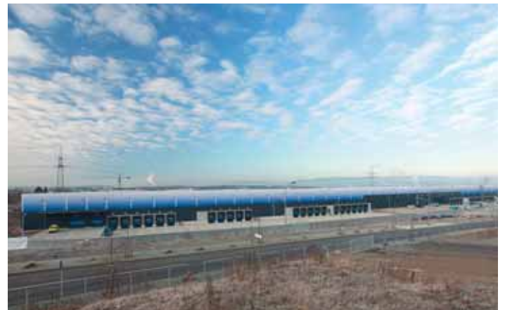
26 Logistikimmobilie im Güterverkehrszentrum in Kassel
