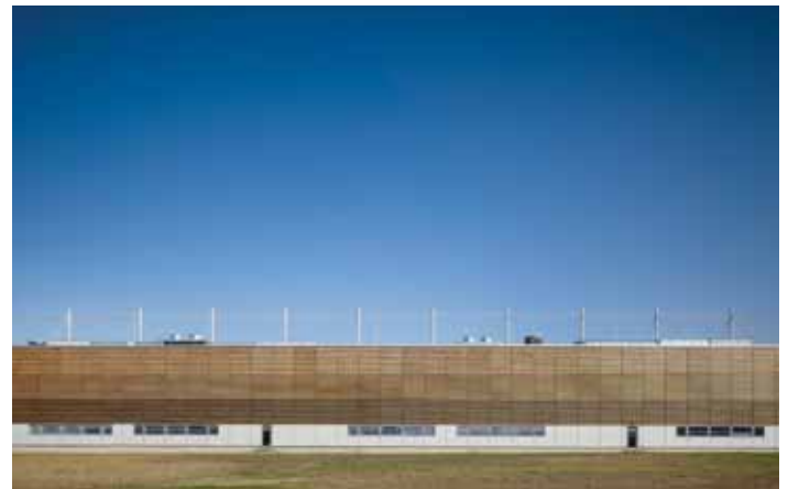
18 Auffälliges Tragwerk in Ostwestfalen
