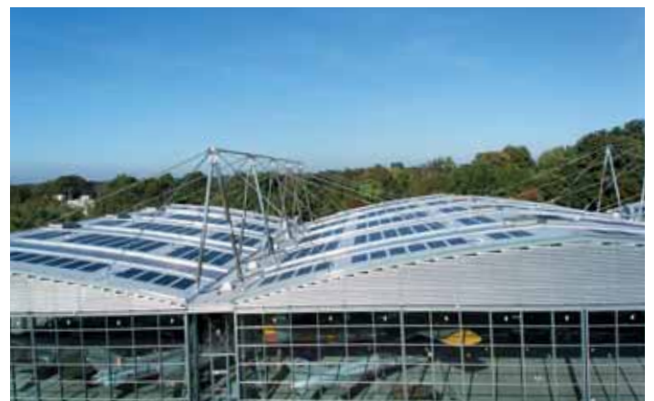
36 Flachdach in Schleißheim: Neue Dachbahn
