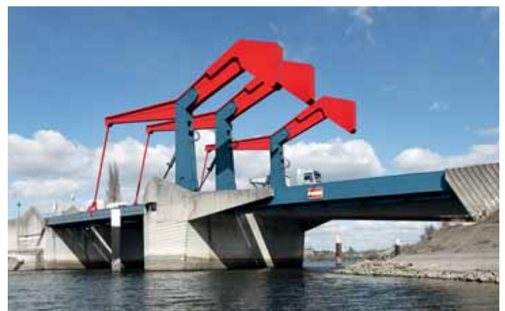
64 DGNB-Kennzahlen für Korrosionsschutz
