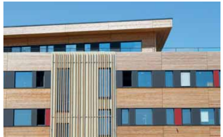
20 Energieeffiziente Firmenzentrale in Holzskelettbauweise
