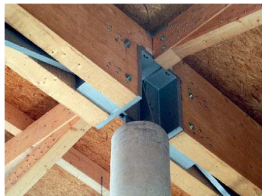
Foto: JUHR, Architekturbüro für Industriebau und Gesamtplanung
